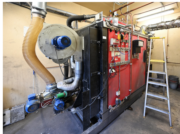
Den gamla pelletspannan har plockats ut ur pannrummet i Klosteräng i Lödöse.
