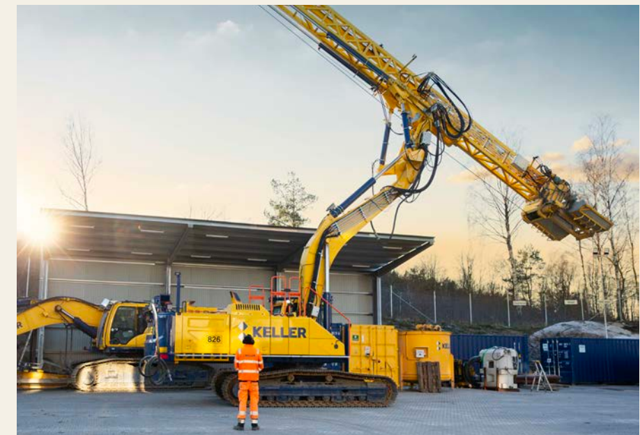
2000 kubikmeter berg var bortsprängt för att ge en funktionell rangergård.
